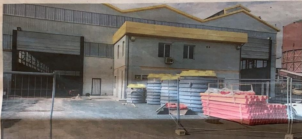
Il capannone da 2600 metri quadrati acquistato sul porto da Agroittica, dove sono in corso i lavori per realizzare la nuova fabbrica
